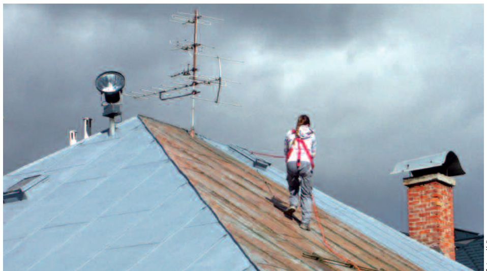
Das Dach des Bergerhauses wird neu gestrichen
